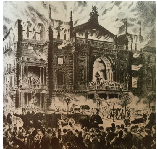
Theaterplatz während des Brandes
